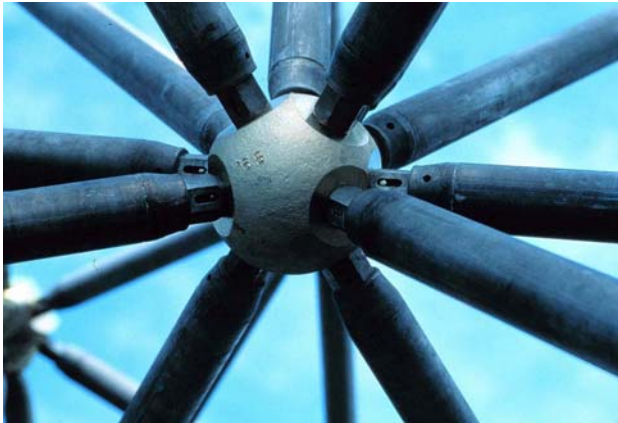
Figure 14.1. HET Truss Node
